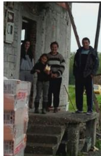
In Zivinice werd een woning voorzien van ramen, deuren, douche en keuken
